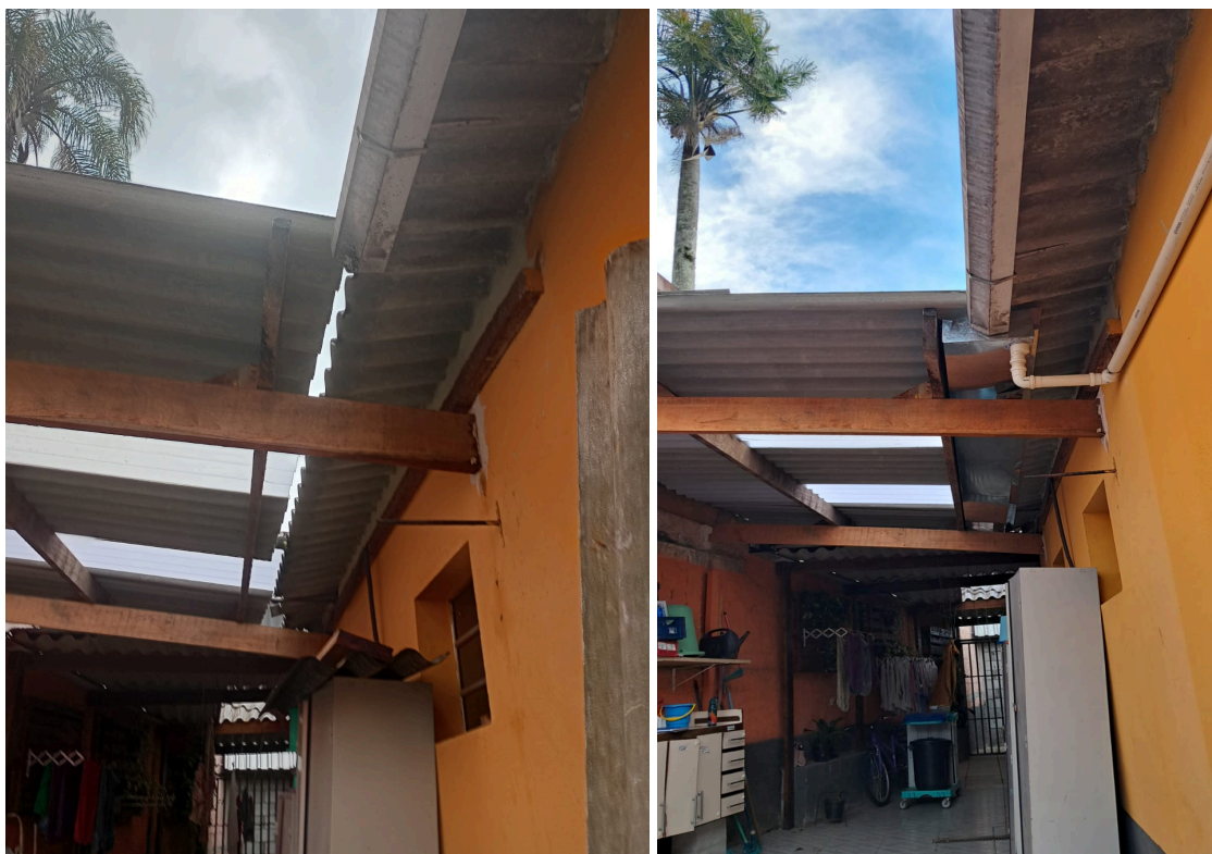
Processo de instalação de calha.
