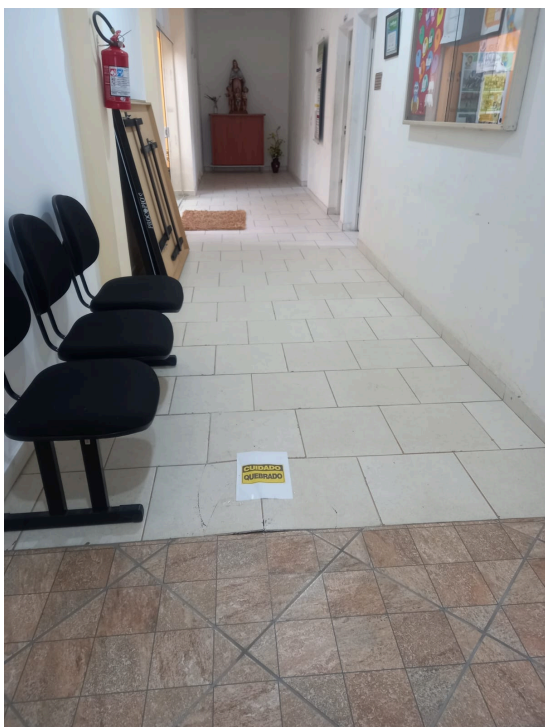
Piso do corredor antes da substituição, apresentando descolamento e falta de padronização.
