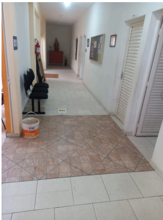
Piso do corredor antes da substituição, apresentando descolamento e falta de padronização.
