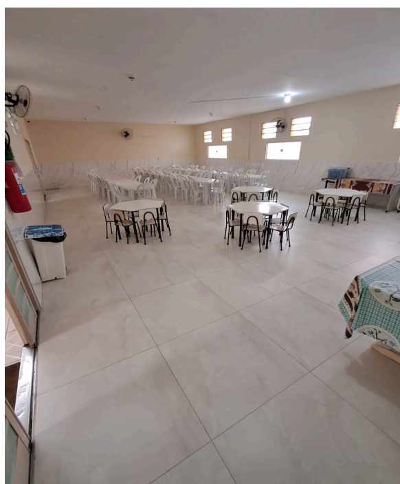
Refeitório após a instalação de revestimento em porcelanato e pintura.
