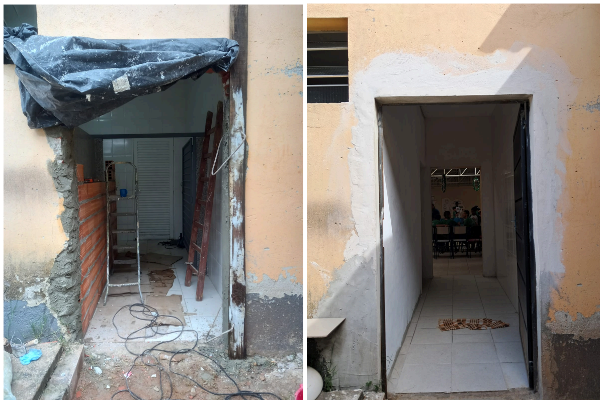
Processo de adequação estrutural, criando acesso entre o pátio e a quadra.
